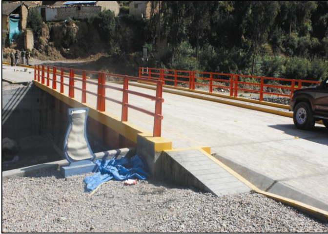
Construcción del Puente Vilcacoto-Huancayo
