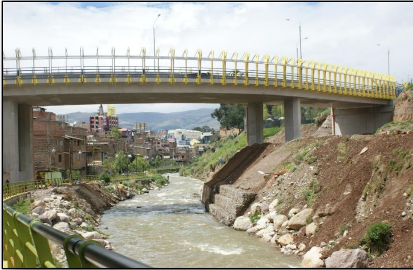
Construcción del Puente Amazonas
