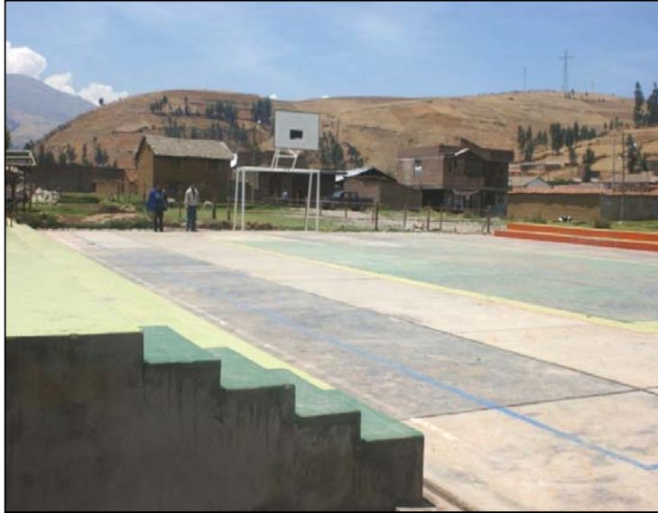
Construcción Losa deportiva Anexo de Cochabamba
