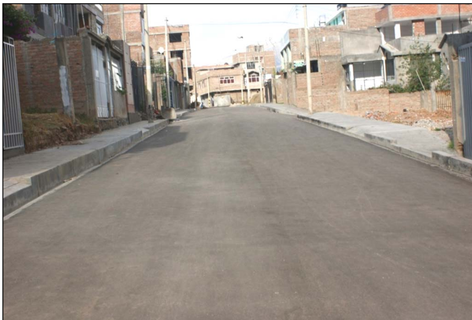
Pavimentación Calle Baritina – El Tambo
