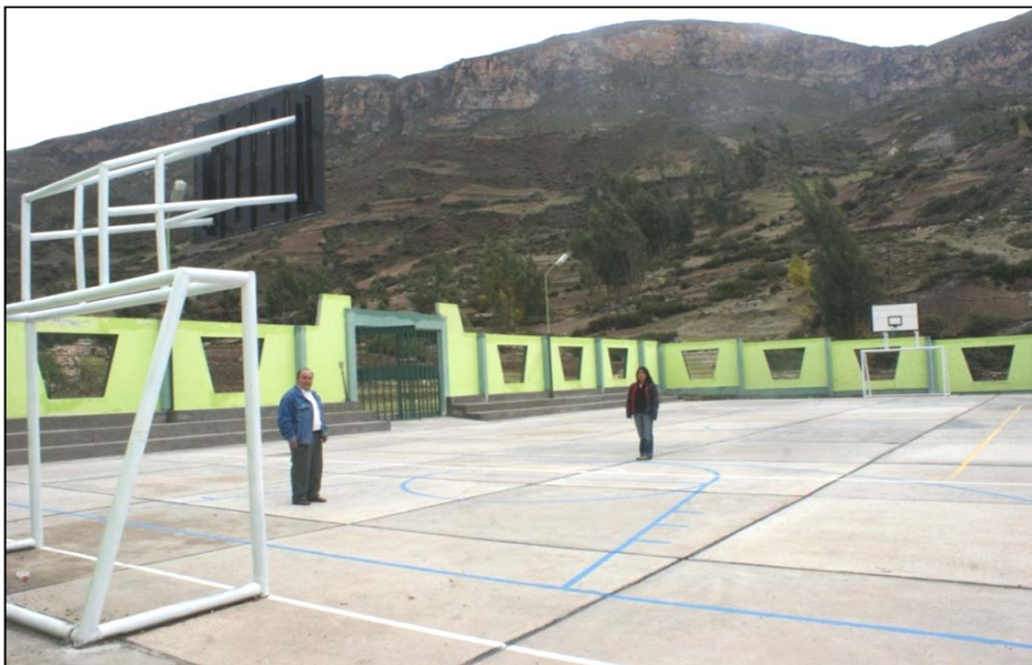
Construcción Losa deportiva en Barrio Chaya - Colca
