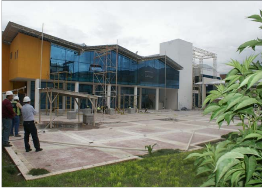
Construcción Expo Feria Wanka – II Etapa.
