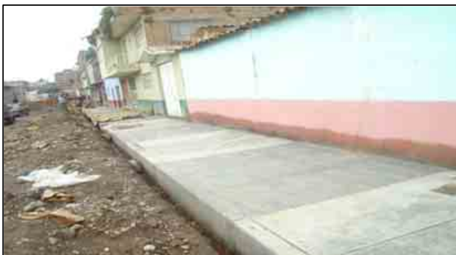
Construcción de veredas Juntas Vecinal Madre Wanka
