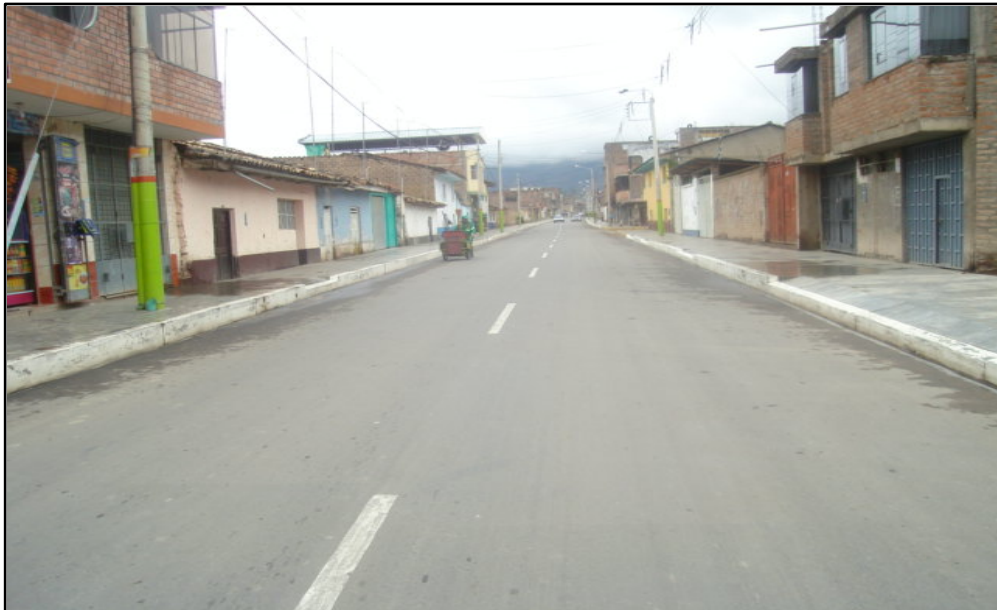
Pavimentación Jr. Loreto tramo: Av. Hvca – D.A. Carrión
