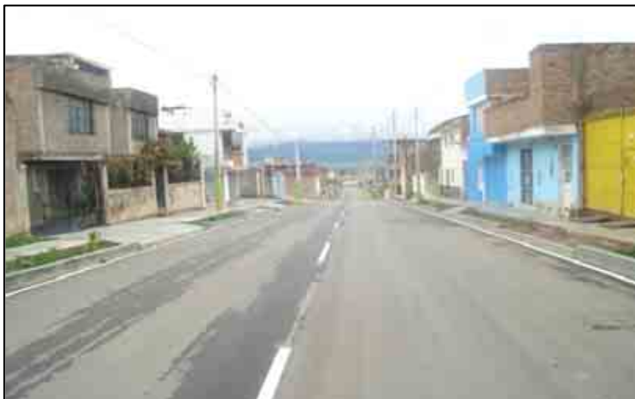
Pavimentación. Jr. Cuzco tramo: Jr. Tacna – Jr. Carrión
