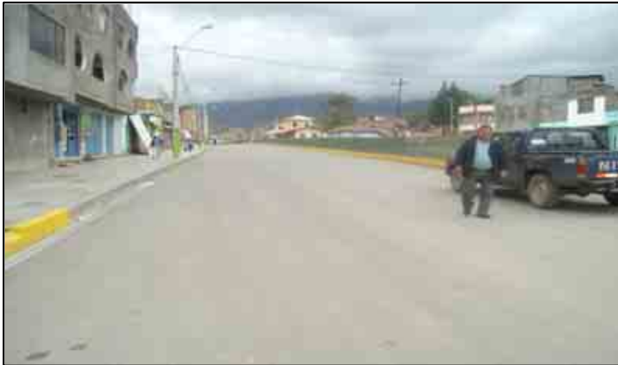
Mejoramiento Vial Av. Ferrocarril tramo: Real – Av. Hvca.
