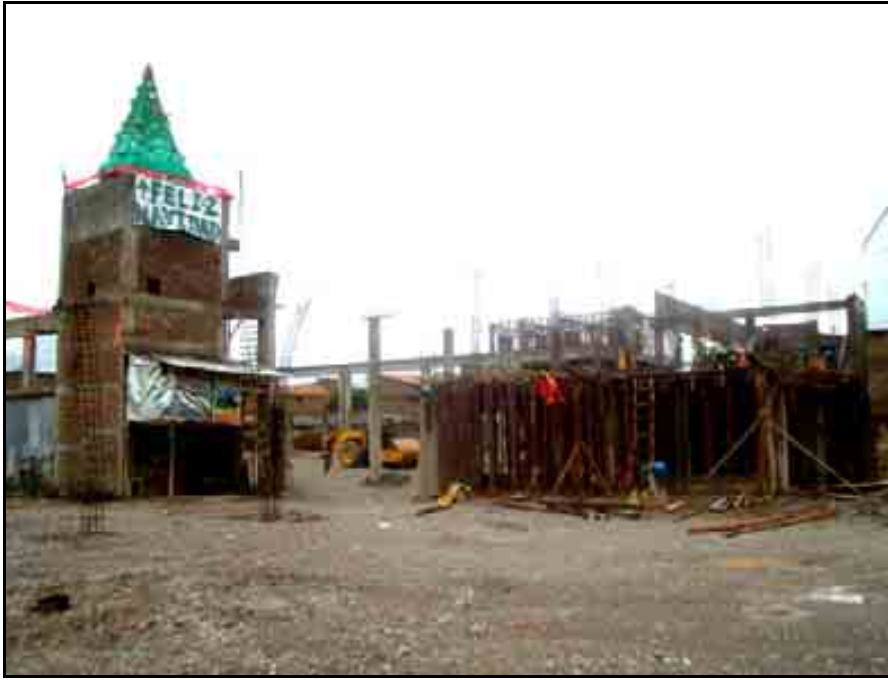
Construcción e Implementación Expo Feria Wanka – II Etapa
