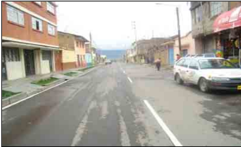
Pavimentación. Jr. Cuzco tramo: Jr. Tacna – Jr. Carrión
